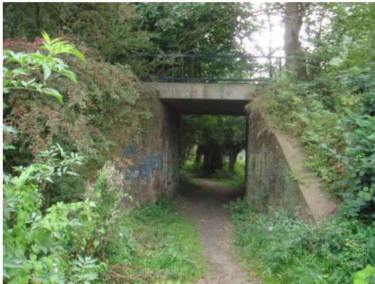
Mijnwerkerspad op talud
