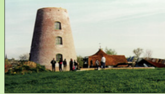
Als een fenix verrees de Verrebeekmolen uit de puinen, opgebouwd met liefde en vakmanschap. De Saracenenkap ligt klaar om erop geplaatst te worden. Deze kap weegt circa 13 ton.
